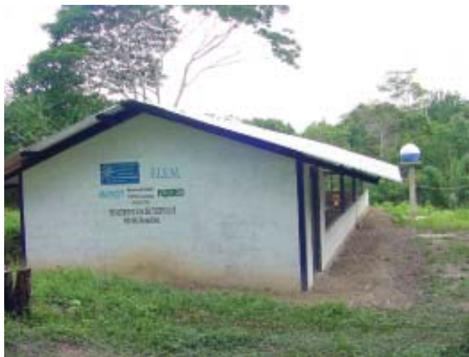
Figura 10. Aspecto del galpón construido por un productor en Amazonas. En este caso colocó tres hileras de bloque en la parte inferior de las paredes externas
